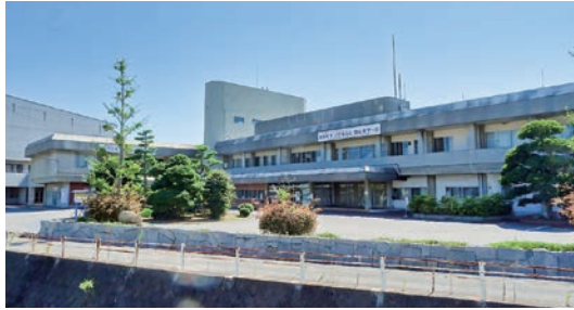
耐震補強等が予定される波方支所（公民館）
